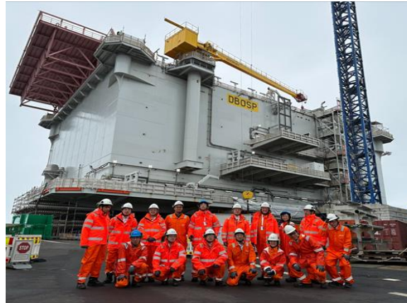
1.2GW洋上変換所の製作現場
