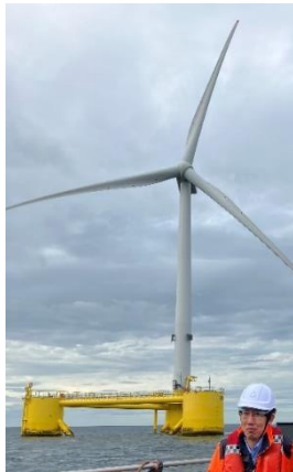
9.5MW浮体式洋上風車
