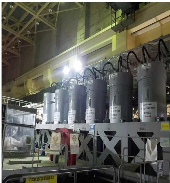
図 1 第三セシウム吸着装置
