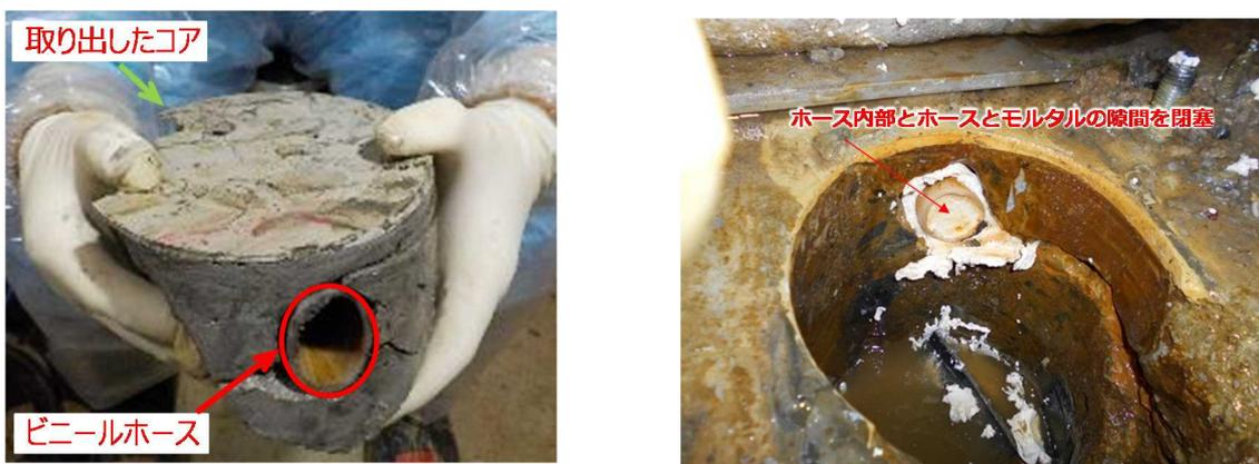
図 3 サイトバンカ建屋 流入経路コア抜き調査状況及び止水対策実施状況
