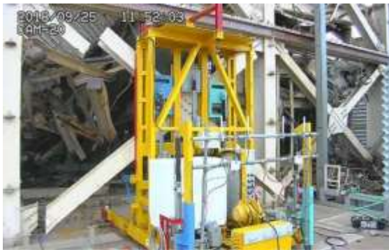
左；Xブレース撤去作業
