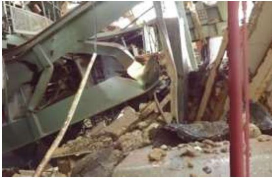
左；燃料取扱い機等のガレキの状況
