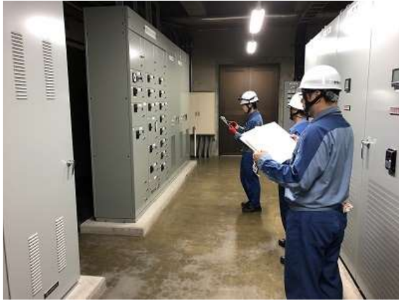
現場操作競技会（電源確認）
