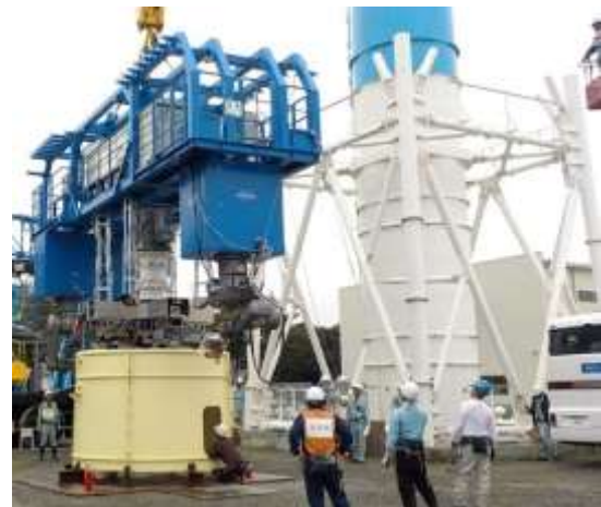
遠隔解体装置(左)、模擬排気筒(右)
