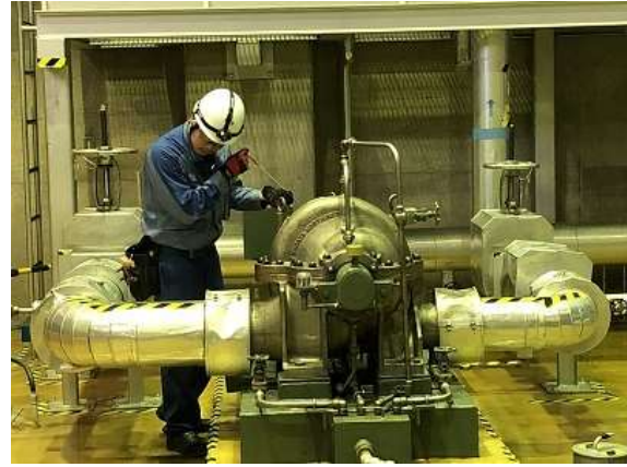
現場操作競技会（ポンプ起動確認）
