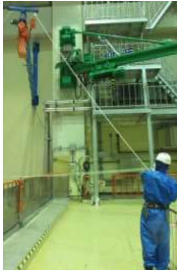
福島第一の仮設ディーゼル発電機及びジブクレーンの配備
