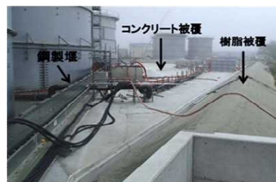
図 タンク堰の二重化・内堰の嵩上げ・堰内被覆
