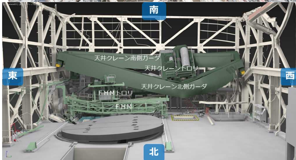
図 1号機オペレーティングフロアのガレキ状況と 天井クレーン・燃料取扱機状況イメージ
