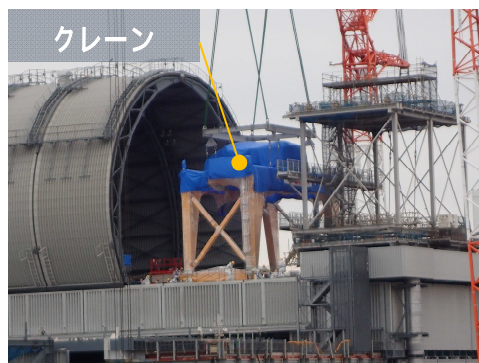
クレーン設置風景 (2017年11月20日撮影)
