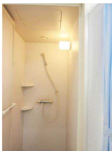
図 大型休憩所内シャワー室
