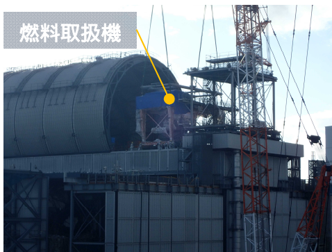
燃料取扱機設置風景 (2017年11月12日撮影)
