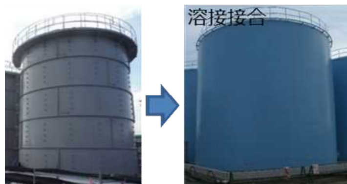
図 フランジ型タンクリプレース
