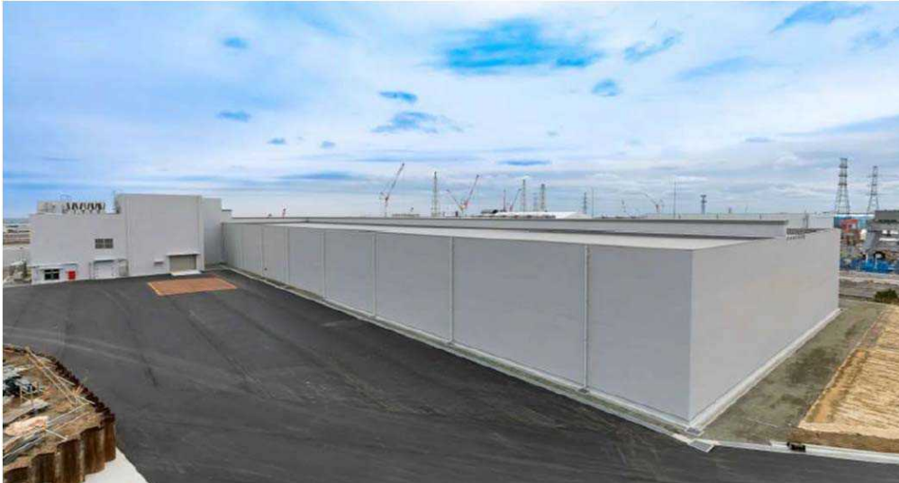
図 固体廃棄物貯蔵庫第9棟外観
