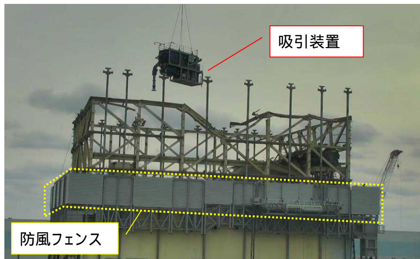
図 1号機ガレキ撤去作業状況(2018年1月22日撮影)
