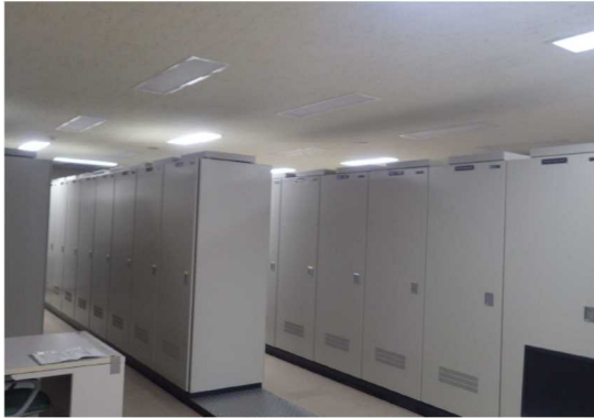
改修前（旧プロセス計算機室）
