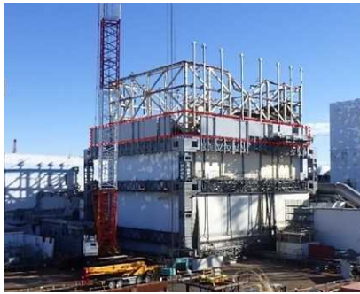
1号機防風フェンス設置（赤枠部分）
