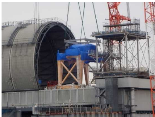
ドーム屋根設置作業（左：クレーン搬入、右：ドーム屋根搬入）
