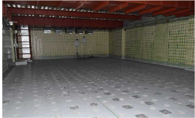
改修中（遮蔽壁設置用アンカー打ち準備）
