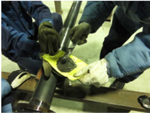
配管ダクト補修訓練
