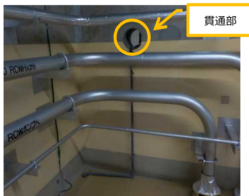
防火処置未実施の貫通部（2号機原子炉建屋地下1階）
