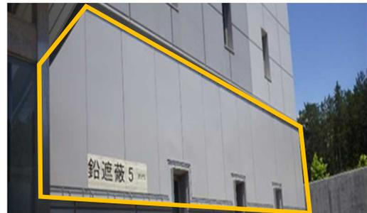
免震重要棟外壁部に設置した鉛板の遮へい材
