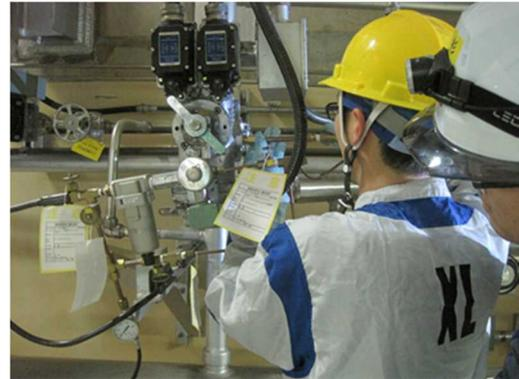
空気作動弁への制御用空気注入加工（左：空気注入機材一式 右：接続操作）
