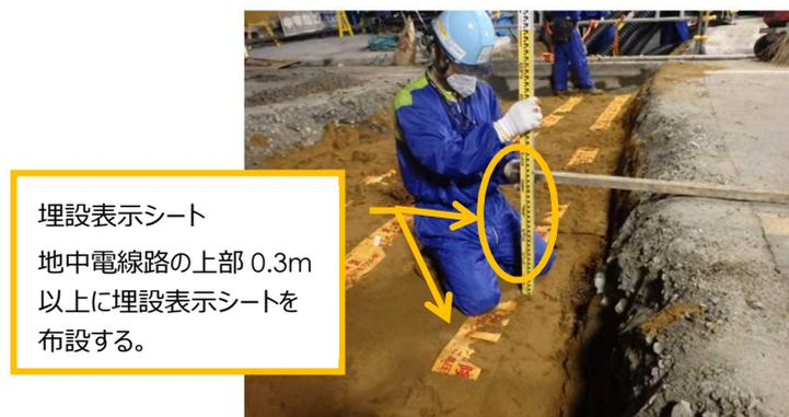
地中電線路の上部への埋設表示シート布設（福島第一）
