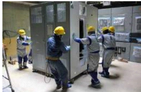
1号機 電源盤(P/C 1G-1)据付作業
