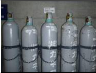
予備ポンベの配備
