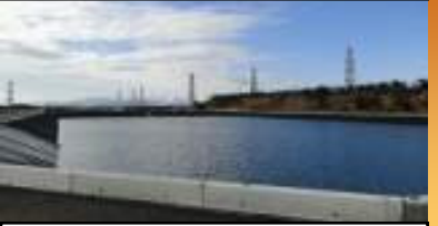
淡水貯水池設置
