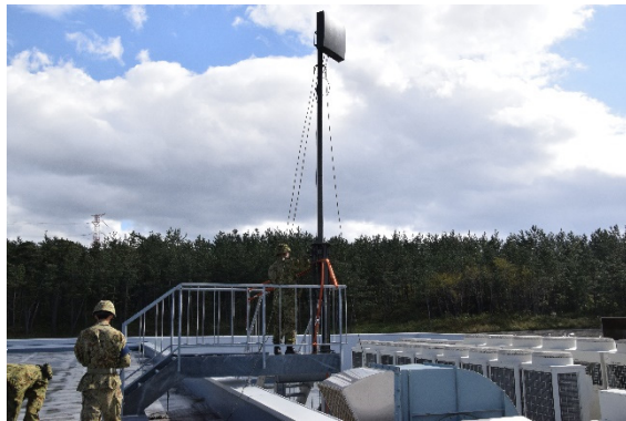
屋外アンテナの設置
