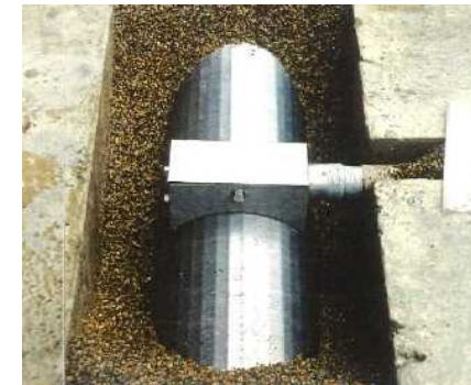
写真2 集水管敷設状況
