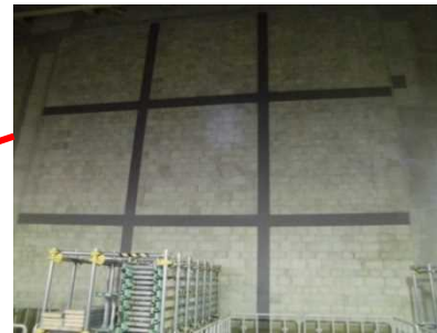
ブロックアウト壁外観
