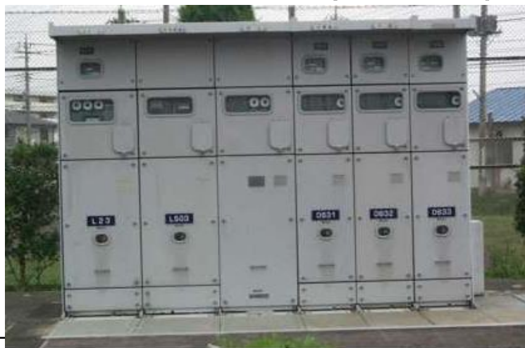
遮断器 + 開閉器 (6.6kV用)
