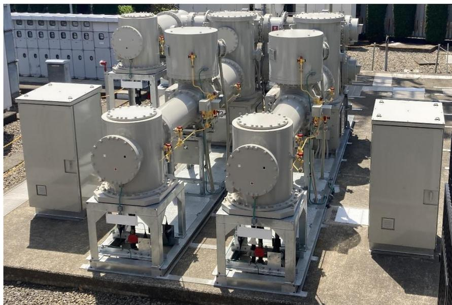
国内電力初のSF<sub>6</sub>ガスを使用しない66kV GIS
