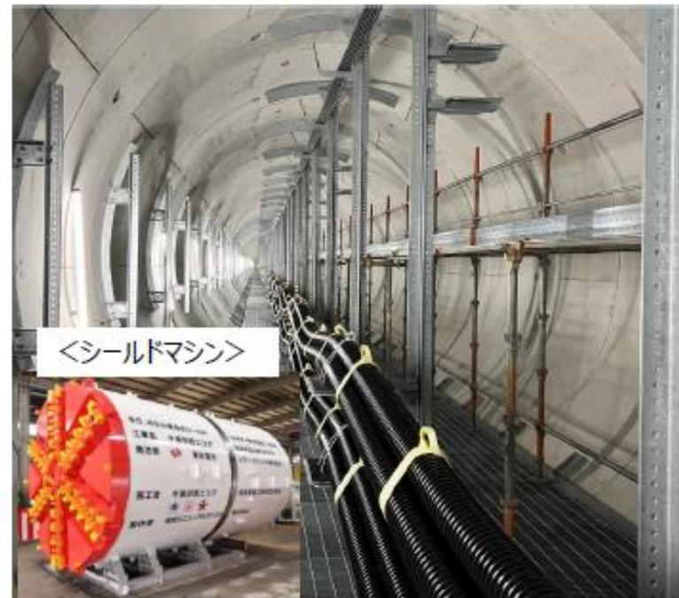
※当該規模の洞道工事は、計画から竣工まで8年程度かかるが、4台のシールドマシンを投入し、約4年9か月の工期に短縮
