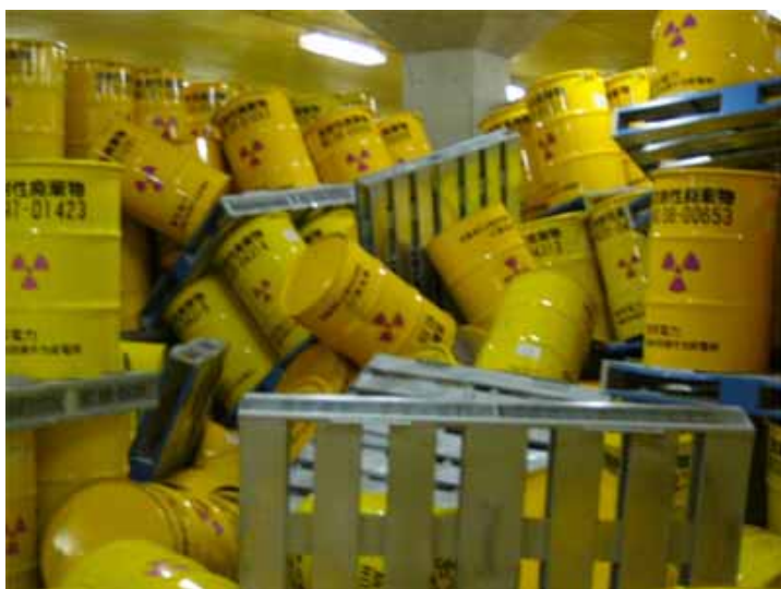
11 . 固体廃棄物貯蔵庫のドラム缶転倒状況
