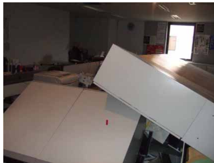
10 . 事務本館什器転倒状況
