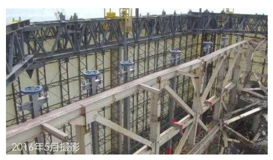
散水設備ノズルユニット設置状況(東面)
