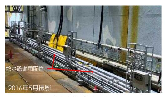
散水設備配管設置状況 (原子炉建屋東側下屋)
