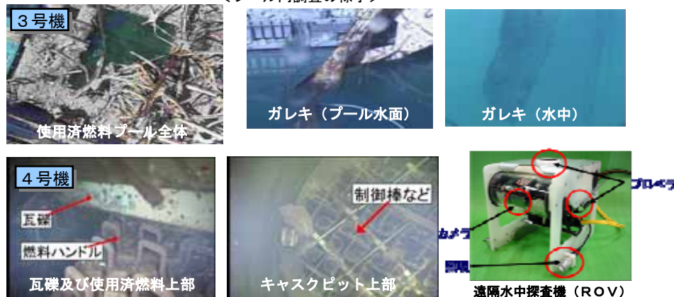
＜プール内調査の様子＞
