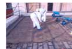
事務本館屋上コンクリート撤去
