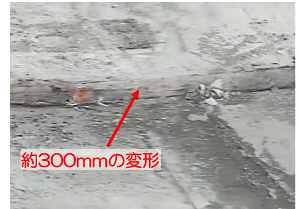
写真①シールドプラグの変形状況
