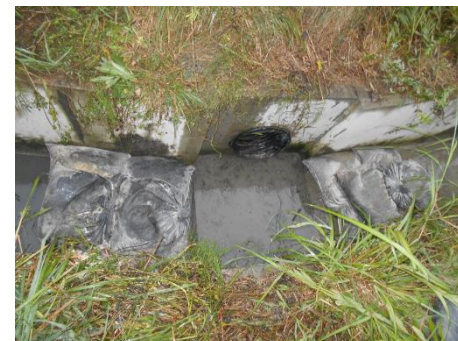
図4 応急対策 (土のう設置)
