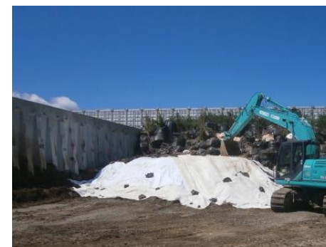
図3 応急対策 (シート養生)
