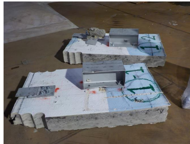
壁解体（STEP6） 2018/5/28撮影
