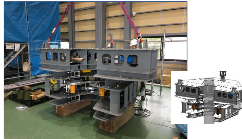
鉄塔解体装置（支柱材用）組立状況
