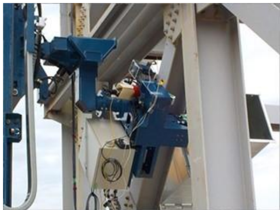
セーバーソーによる切断
