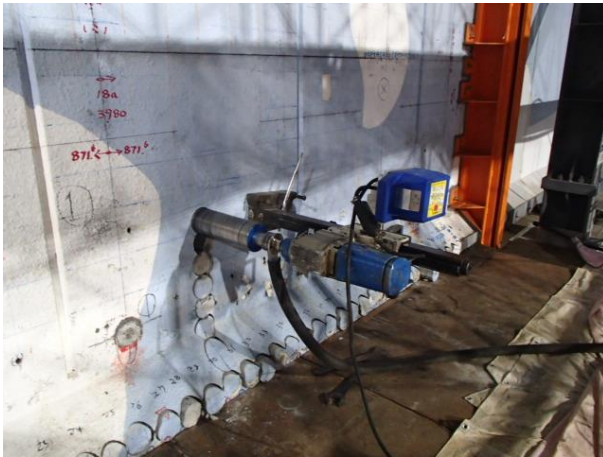
解体用コア削孔（STEP3） 2018/4/24撮影
