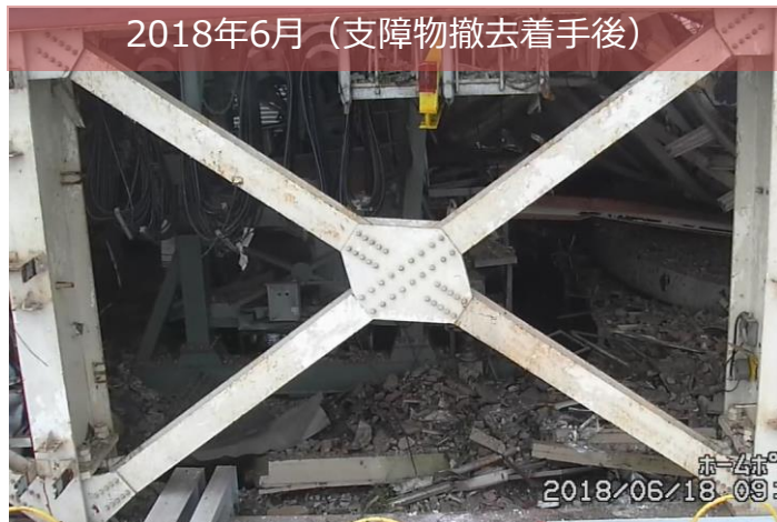
支障物撤去の状況（東面）
