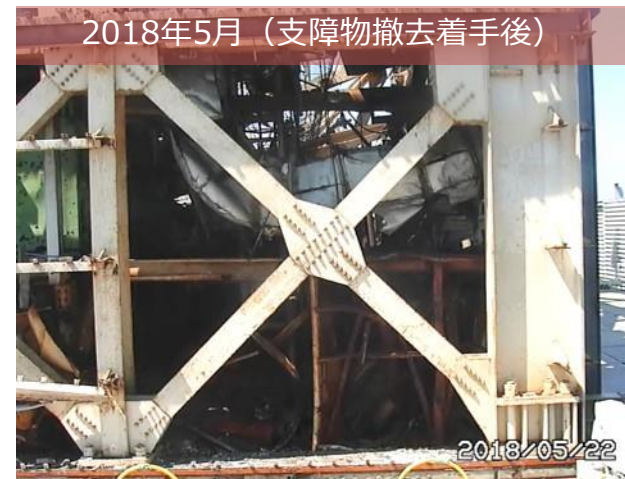
支障物撤去の状況（南面外部側）
