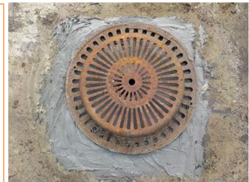
【2号機R/B雨水配管補修状況】
