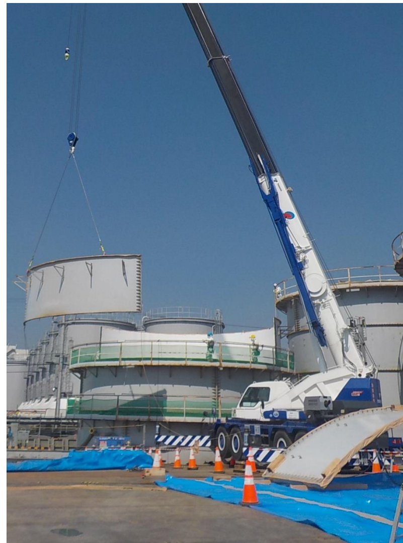
H6北エリア フランジタンク解体状況
