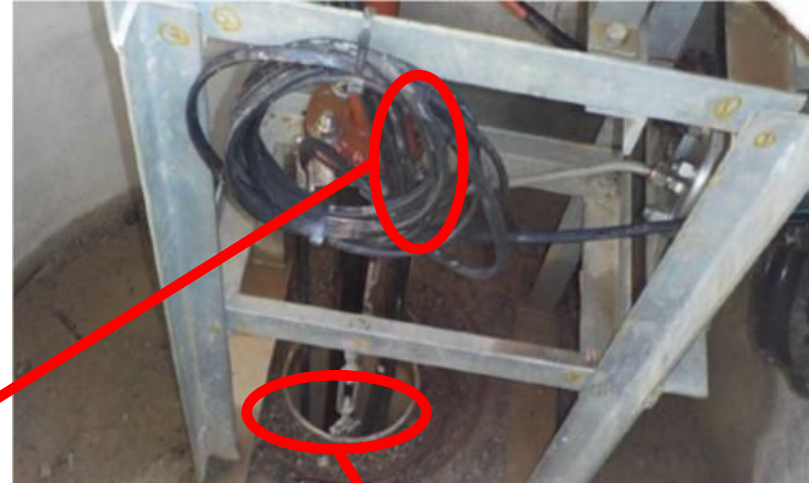
マンホール内部
