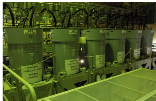
SARRY II 吸着塔設置状況 (左側2塔:ろ過フィルタ, 右側4塔:吸着塔)
