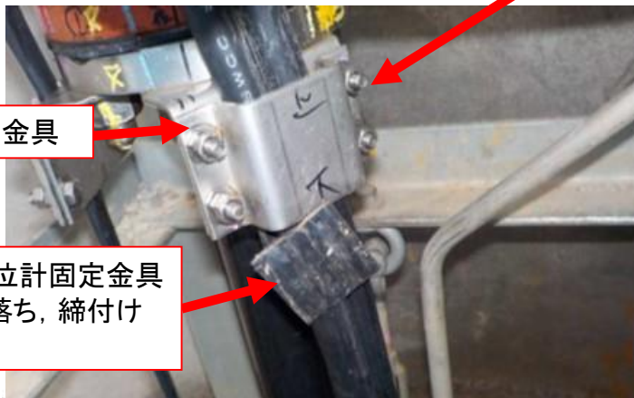
通常は水位計固定金具下にある基準を示すマーキング
