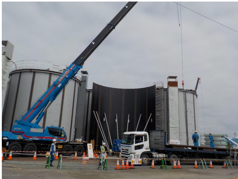
H5エリア タンク建設状況
