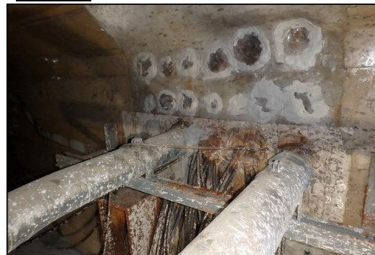
2号機取水電源ケーブルトレンチ貫通箇所 止水状況
