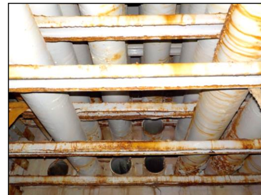
1号機共通配管トレンチ貫通箇所
