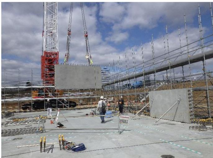
② 1階プレキャストコンクリート壁設置
