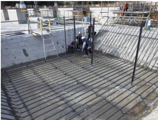
② 基礎配筋
