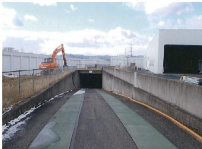
地下貯蔵庫入口斜路
