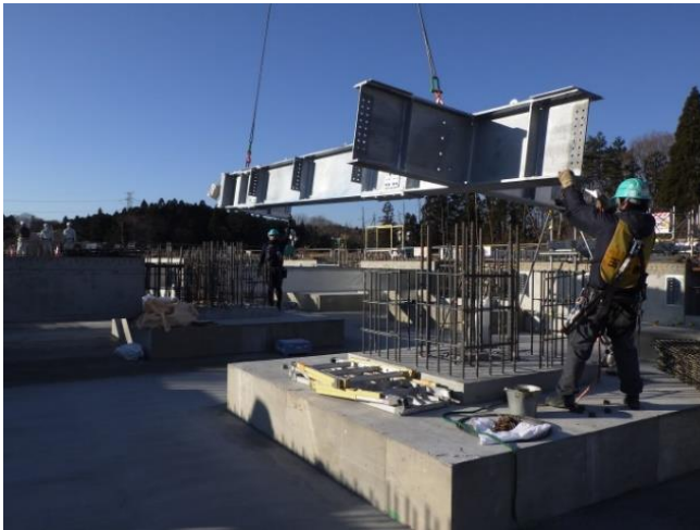
① 1階鉄骨梁設置
