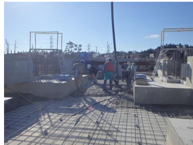
③ 土間コンクリート打設
