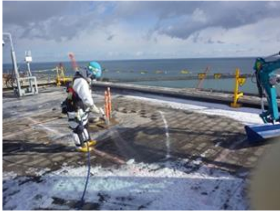
①屋根保護層撤去前散水状況
