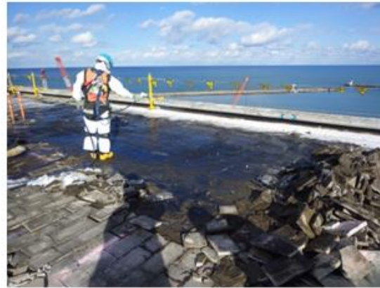
⑤屋根保護層撤去後散水状況
