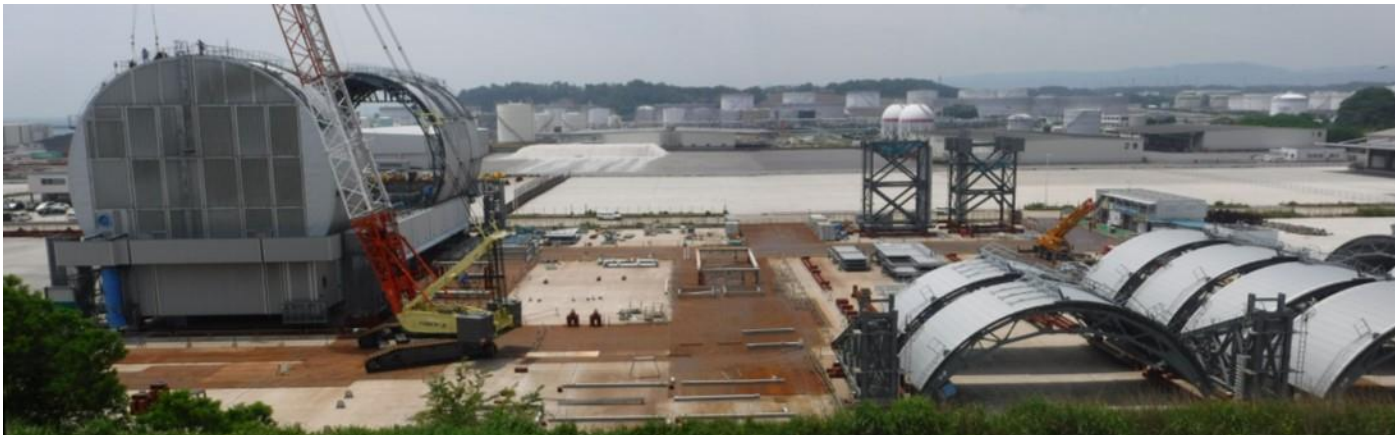
小名浜港でのステップⅥ，Ⅷ訓練状況写真
