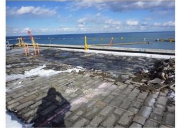
③遠隔重機による屋根保護層撤去完了状況
