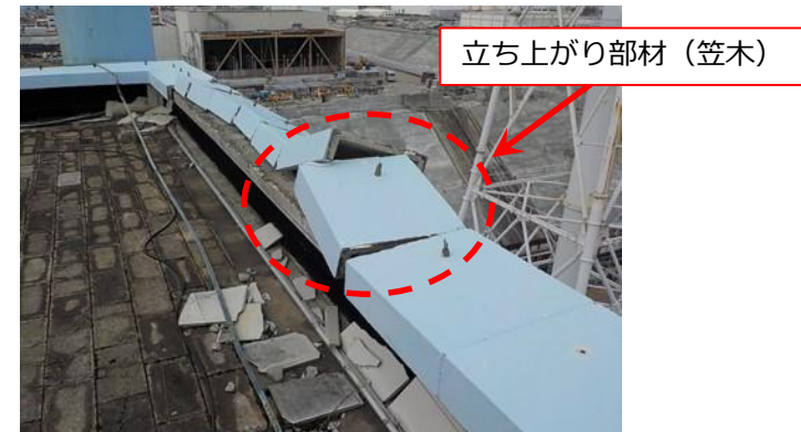
立ち上がり部材 (笠木) 状況
