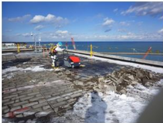
④残砂の清掃状況
