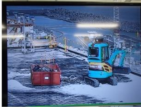
②遠隔重機による屋根保護層撤去状況
