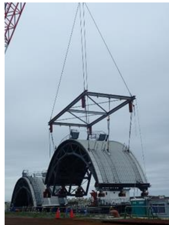
ドーム屋根搬入状況（撮影日2017年6月27日）
