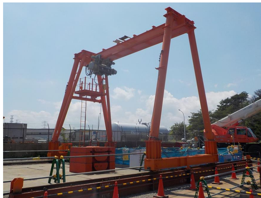
工事の状況 (推進立坑門型クレーン設置：7月11日現在)
