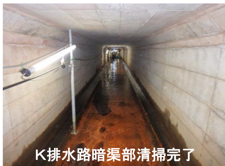
K排水路暗渠部清掃状況
