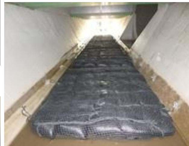
排水路浄化材設置状況
