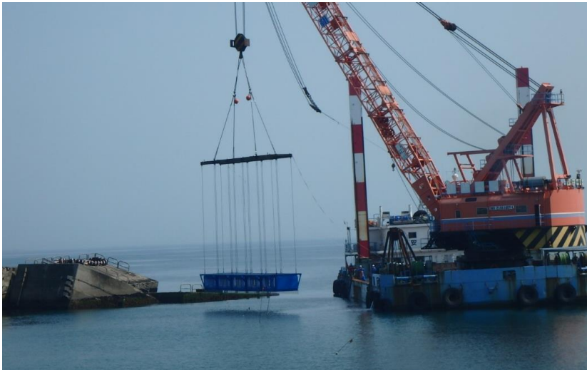
設置状況（作業全景）
