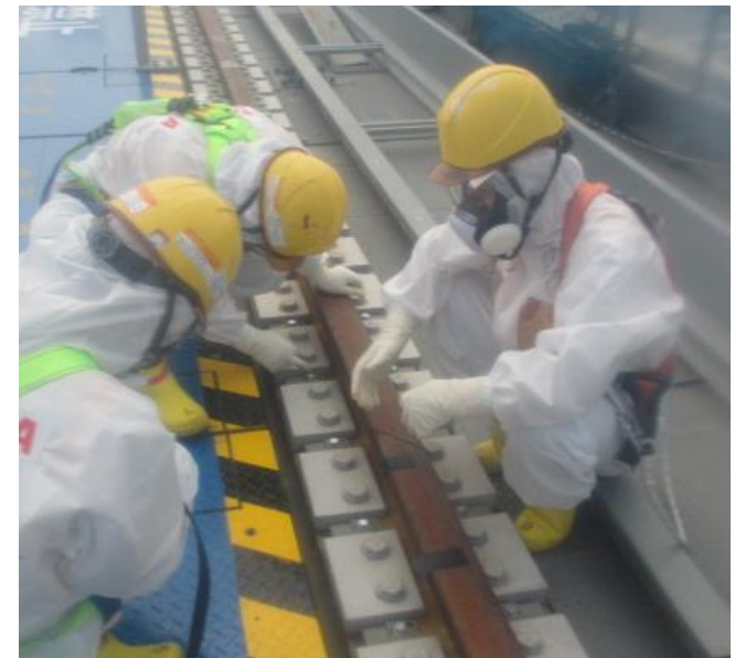
走行レールの調整作業状況
