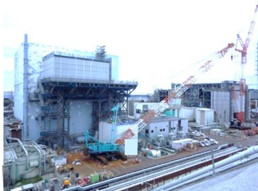
2号機原子炉建屋 全景（2017.6.27撮影）
