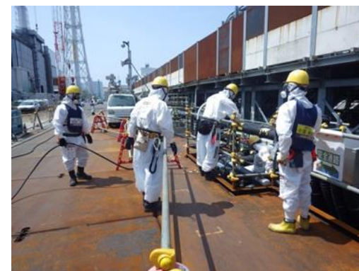
写真③ ケーブル敷設作業状況
