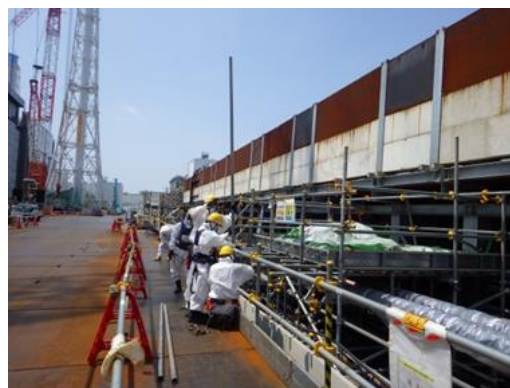
写真② 無線通信用アンテナ架台設置状況
