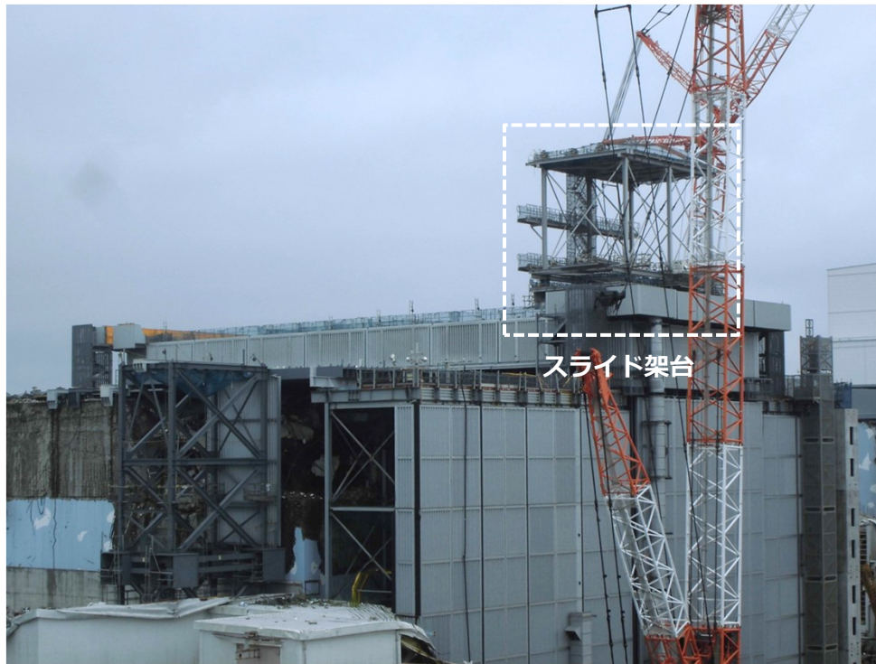
スライド架台組立状況（撮影日2017年7月26日）
