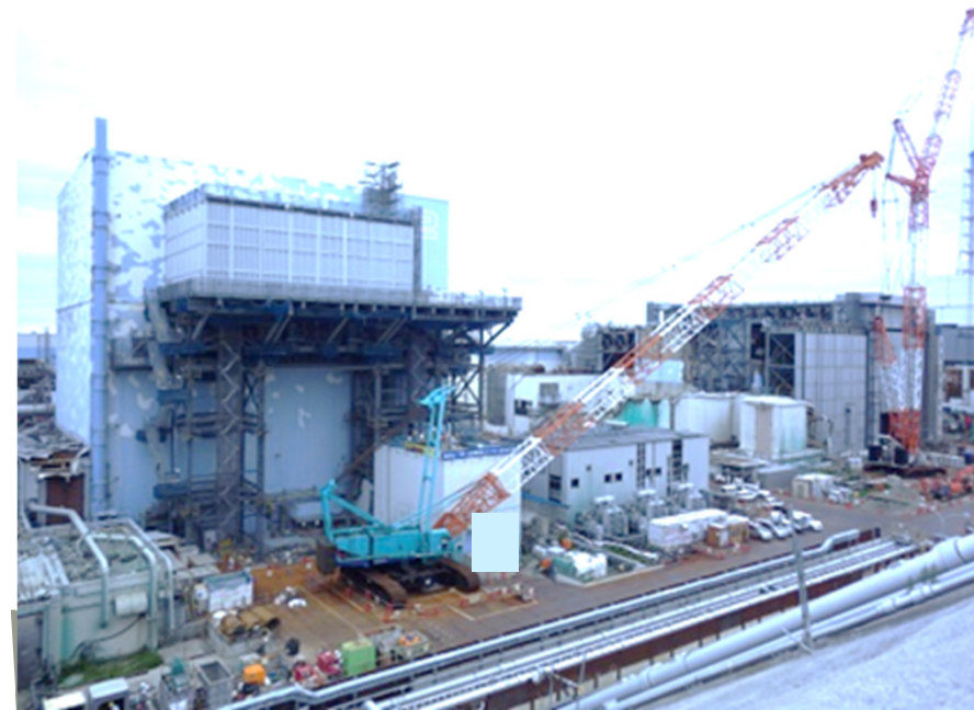
2号機原子炉建屋 全景（2017.6.27撮影）
