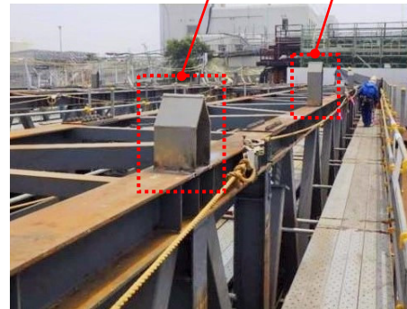
カバー梁改造 撮影：H29.7.10
