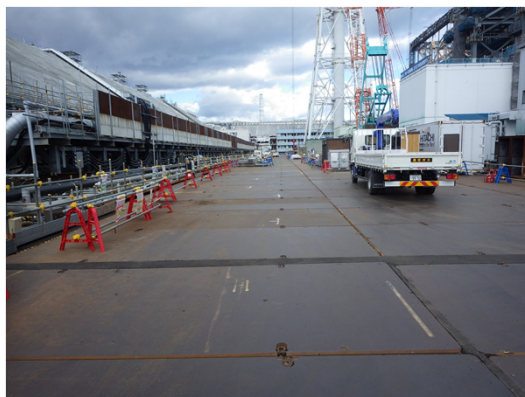
写真① 西側路盤整備完了
