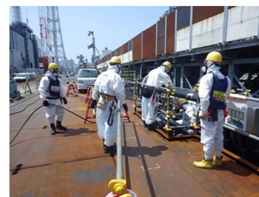
写真③ ケーブル敷設作業状況
