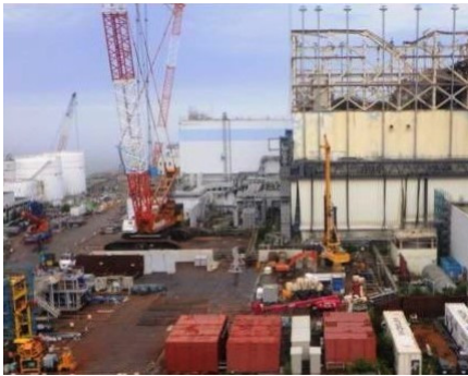
工事エリア全景 撮影：H29.7.24
