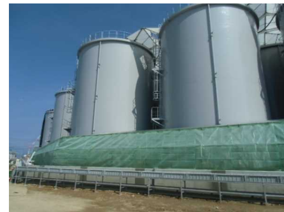
タンク堰カバー・雨樋
