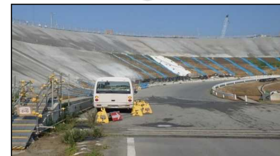
モルタル吹付け施工状況
