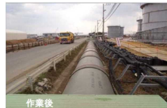
作業後 B排水路暗渠化
