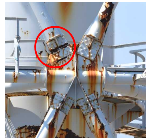
破断箇所（例）
