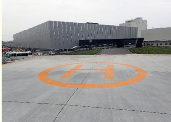
<ヘリポート（新事務本館入口近傍）>
