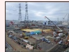
H1東エリア解体後の様子
