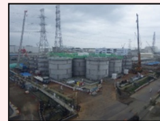
H1東エリア解体開始時の様子
