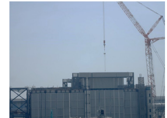
3号機燃料取り出し用カバー設置状況 (2017/5/22)
