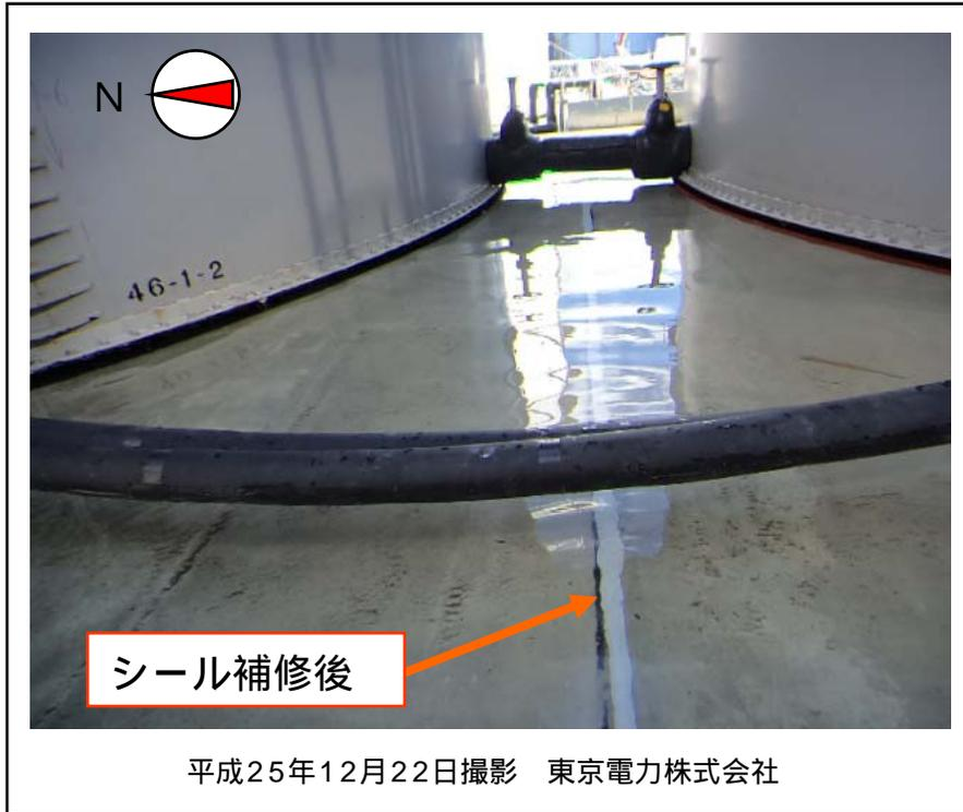
【H5タンクエリア西側堰のシール補修状況】
