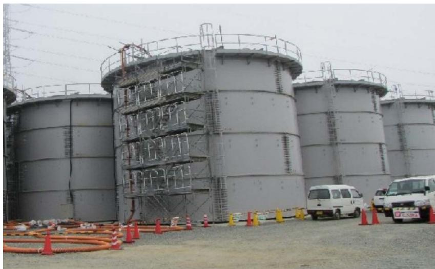
鋼製円筒型タンク（フランジ型）
