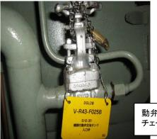
動弁注油タンク補給弁「閉」 チェーンロック実施
