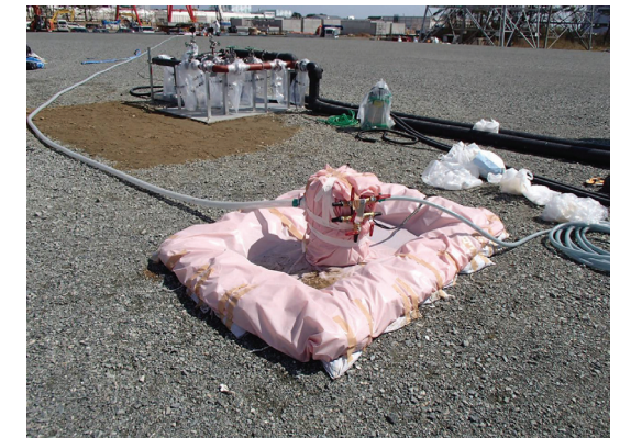
No.3貯水槽のポンプ設置状況(4/13撮影)
