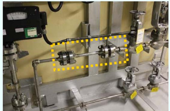
パージライン(B系) 本設配管の接続状況
