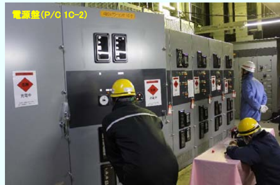
機能確認の様子 【平成25年1月28日本設化完了】 （平成25年1月28日撮影）
