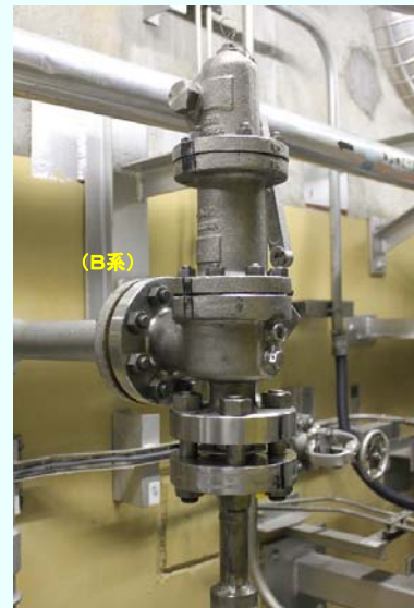
本設配管（弁）接続状況 B系（拡大） （平成25年1月24日撮影）
