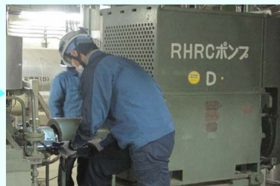
残留熱除去機器冷却系ポンプ(D系)電動機 確認運転の様子 【平成25年1月28日本設化完了】 (平成25年1月28日撮影)
