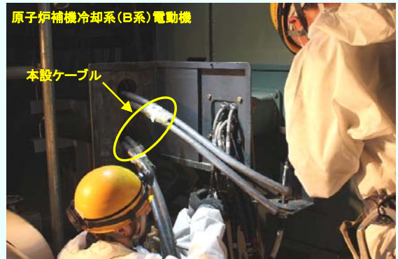
本設ケーブル切替作業前 （平成25年1月25日撮影）
