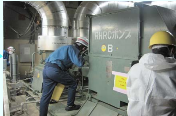
残留熱除去機器冷却系ポンプ(B系)電動機 確認運転の様子 【平成25年1月28日本設化完了】 (平成25年1月28日撮影)
