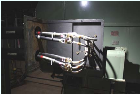
本設ケーブルへの切替完了 （平成25年1月25日撮影）
