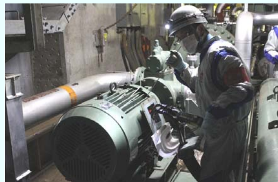
電動機(潤滑油プライミングポンプ※2)確認運転の様子 【平成25年1月31日本設化完了】 （平成25年1月24日撮影）
