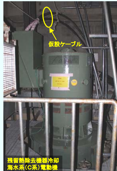
確認運転後の様子 【平成25年1月18日機能確認完了】 (平成25年1月31日撮影)
