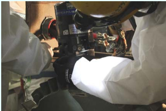
本設ケーブル端子取付作業の様子 （平成25年1月21日撮影）
