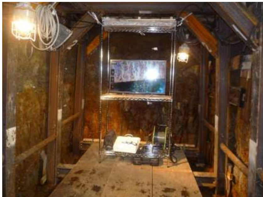
断層部分を掘り下げた 立坑で観察
