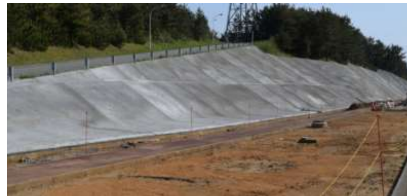
モルタル吹きつけ状況
