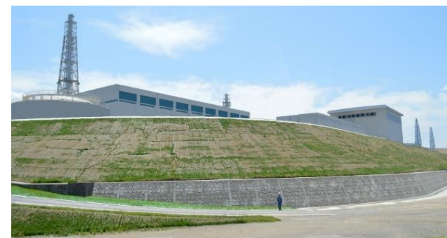
【防潮堤（5～7号機側）】
