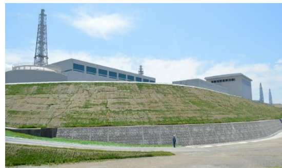
【防潮堤（5～7号機側）】
