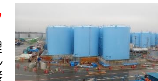
(溶接型タンク設置状況)
