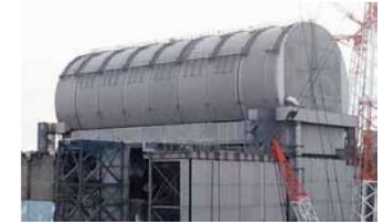
ドーム屋根設置状況 (撮影日2018年2月21日)
