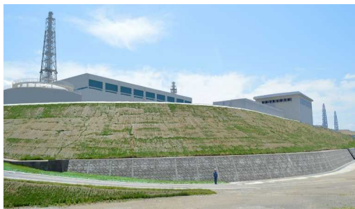
【防潮堤（5～7号機側）】
