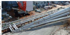
ブライン配管の設置状況
