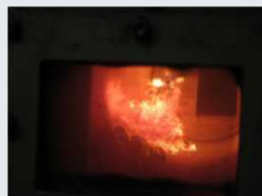
焼却炉内の燃焼状況
