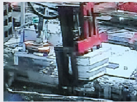
3号機 使用済燃料プール内大型瓦礫撤去作業
