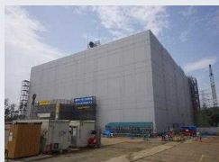
雑固体廃棄物焼却設備外観
