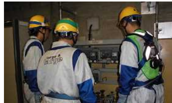
作業現場の危険箇所等のパトロールの様子
