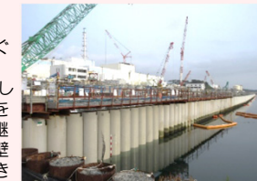
海側遮水壁 鋼管矢板打設完了状況
