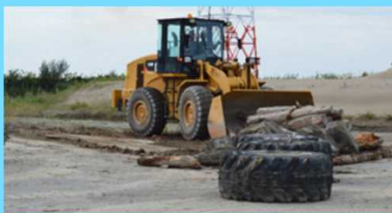
社員による瓦礫撤去車の訓練の様子
