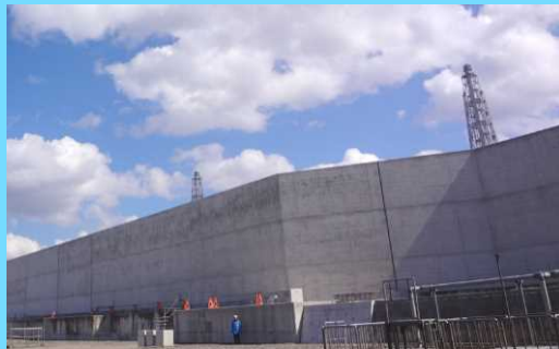
海拔15mの防潮堤の設置
