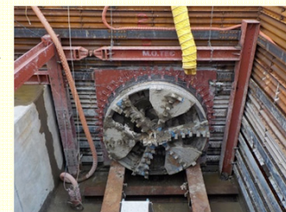
< K排水路付替工事トンネル部の工事状況 >
