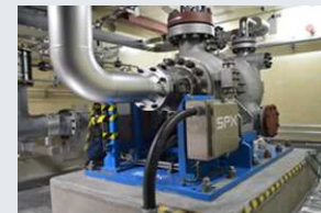
7号機 高圧代替注水系ポンプ (設置工事状況)
