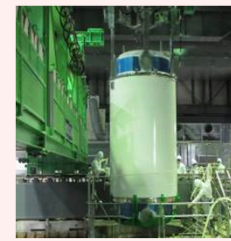
燃料取り出し状況
