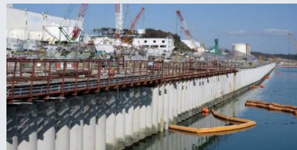
海側遮水壁閉合の完了
