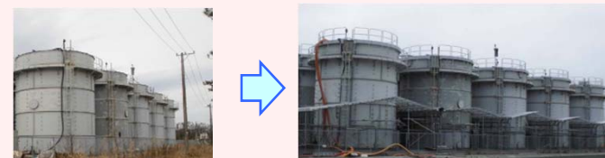
堰カバー設置前
