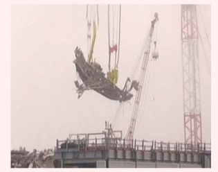
8/2 燃料交換機撤去作業の様子
