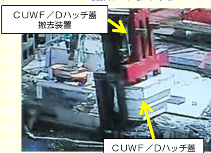
<CUWF/Dハッチ蓋撤去作業状況>
