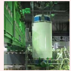
燃料取り出し状況
