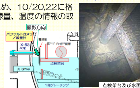
<格納容器内部調査状況>
