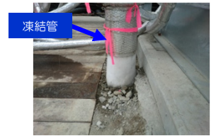
(陸側遮水壁 試験凍結箇所例)
