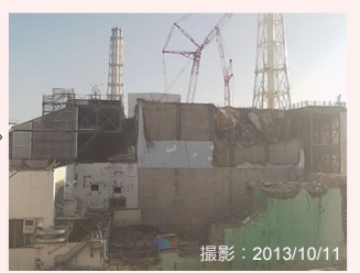
撮影:2013/10/11 大型ガレキ撤去後
