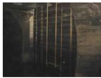
写真-2: 26号角落としの状況(損傷なし)
