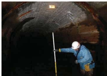
写真-1: 水路の調査・点検
