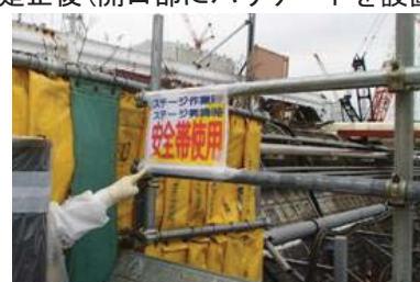
是正後（安全帯使用の標識を設置）
