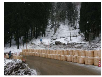
写真-3: 道路管理者による応急復旧状況
