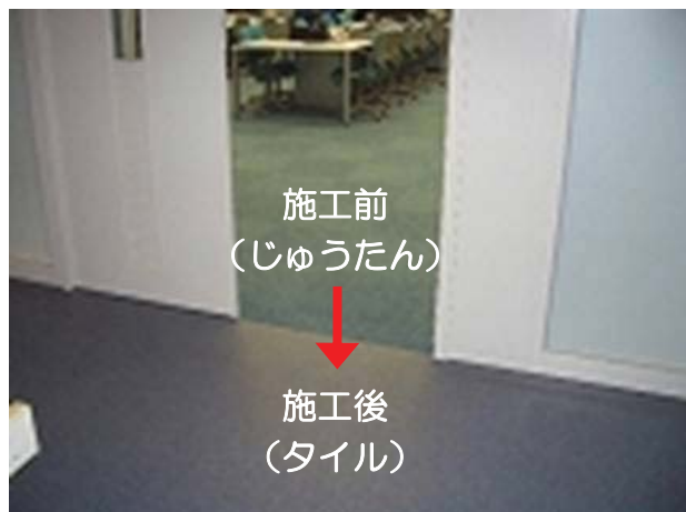
免震重要棟内の床材
