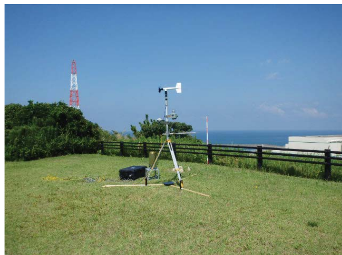
可搬型気象観測設備
