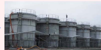
堰カバー設置後
