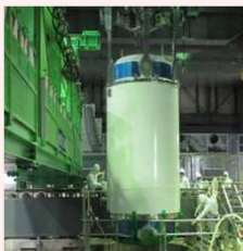
燃料取り出し状況
