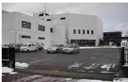
柏崎エネルギーホール
