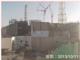
大型ガレキ撤去後
