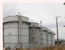
堰カバー設置前
