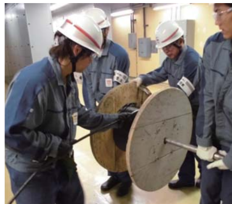
電源ケーブルの敷設訓練
