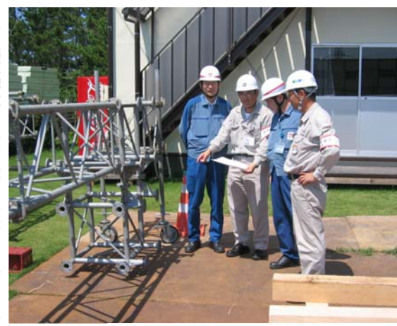
試験施工による安全性確認
