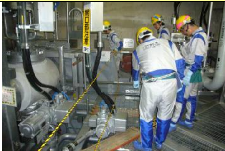
作業現場確認状況
