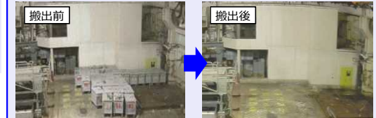
<2号機 原子炉建屋オペフロ南西 残置物の状況>
