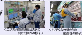
<二次処理性能確認試験に向けた操作の様子>
