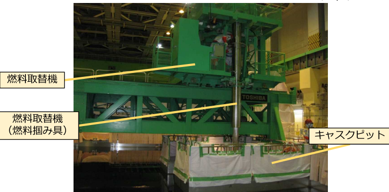
④燃料装填 <6号機使用済燃料プールでの装填作業の様子(7/7,7/8)>
