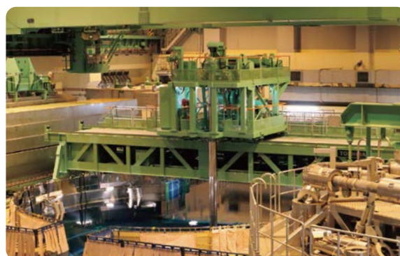
燃料装荷の様子
