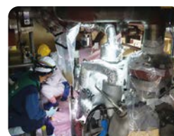
安全対策設備の確認
