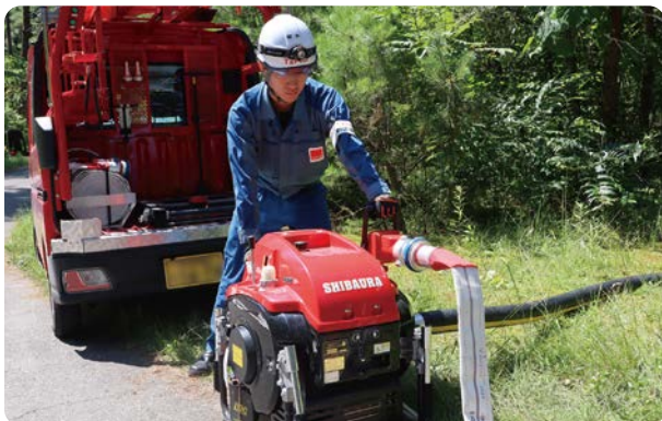
ポンプ本体を点検している様子
