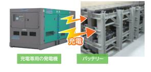
柏崎刈羽原子力発電所では、直流電源設備 (バッテリー) が 浸水などの共通要因で一斉に故障することを防ぐため、 既存の直流電源とは別に原子炉建屋内の 高所 (海抜15m以上) へのバッテリーの増設、 および充電用の発電機の設置を進めています。 これにより、原子炉へ注水する系統の機器へ電源を 長時間供給することができます。
