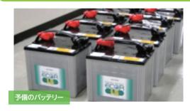
バッテリーは、安全上重要な弁や監視計器などに 直流電源を供給することができます。 福島第一原子力発電所の事故では、津波による浸水の 影響で直流電源を失ったため、その復旧として、 自動車からバッテリーを外して持ち込むなどにより 対応しました。その教訓をふまえ、直流電源を長時間維持 できるよう、予備の可搬型バッテリーを配備しました。
